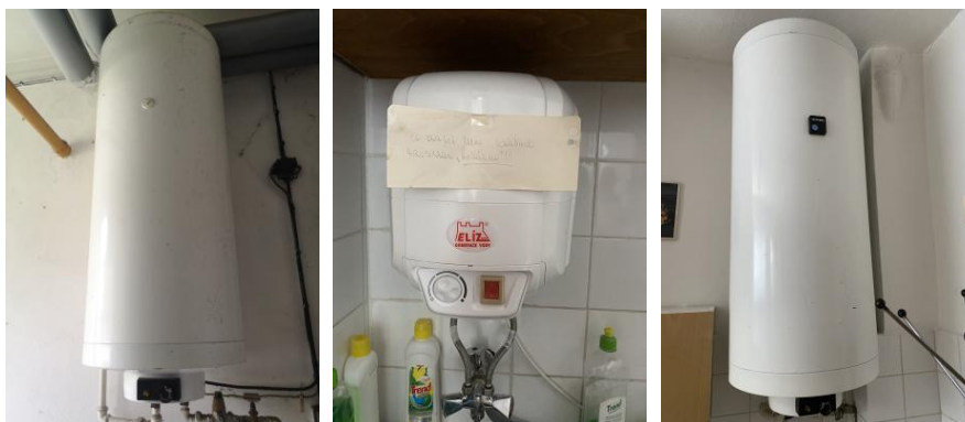
Obrázok 10. Lokálna príprava TV
