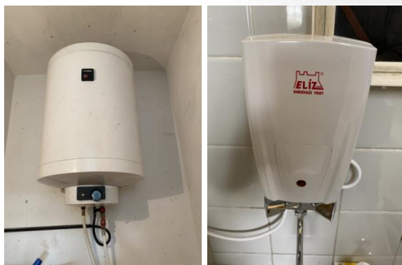
Obrázok 12. Elektrický ohrievač TV (zásobníkový, prietokový)
