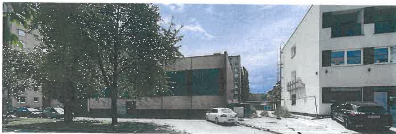
Parc.č. 2475/68, 2475/67, 2475/66 - ul. Jilemnického
