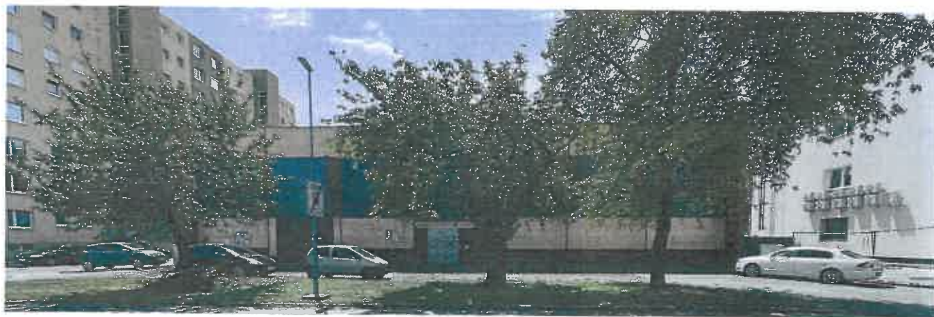
Parc.č. 2475/68 - ul. Jilemnického
