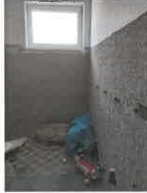
odstránené omietky a obkladačky na prízemí v hygienických miestnostiach
