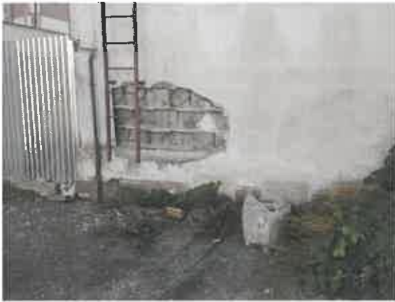
poškodený obklad sokla
