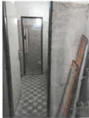
odstránené omietky a obkladačky na prízemí v hygienických miestnostiach
